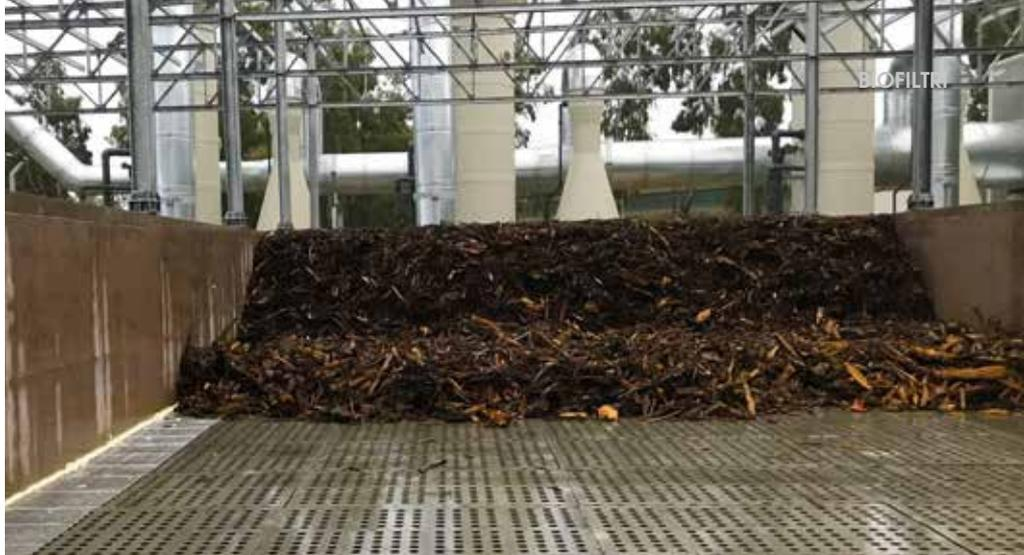
Il Biofiltro è costituito da uno strato di materiale filtrante vegetale (*biomassa*) adagiato su una superficie grigliata. L'aria da trattare è aspirata dalle aree in cui viene prodotta e convogliata nella parte inferiore del letto dove un sistema di distribuzione ne garantisce l'uniformità di ripartizione nella biomassa sovrastante.
